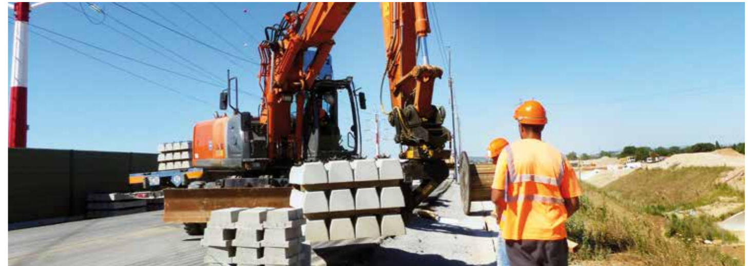
Distribution des traverses
