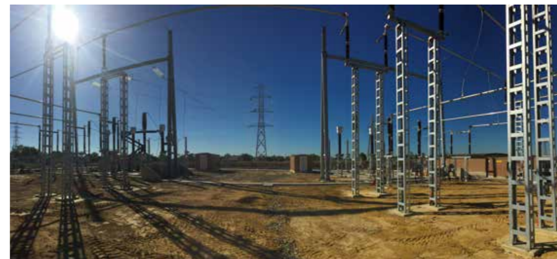
Nouveau pylône et partie RTE de la sous-station
