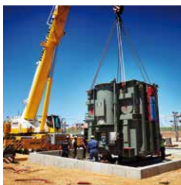
Installation d'un transformateur de traction
