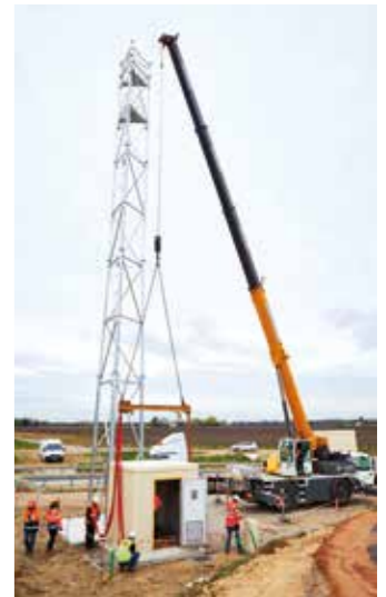
Installation d'un pylône GSM-R et d'un shelter
